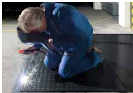
Přivaření na okrajový úhelník – hotovo!
