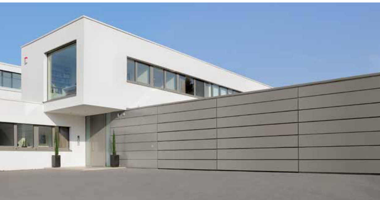
Opláštění hliníkovými sendvičovými deskami v místě stavby
